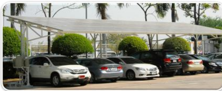
การติดตั้งผลิตภัณฑ์พลังงานแสงอาทิตย์บนหลังคาบริเวณที่จอดรถของบริษัทฯเพื่อผลิตไฟฟ้า 11 กิโลวัตต์ เพื่อใช้ในบริเวณล๊อบบี้ของบริษัทฯ
