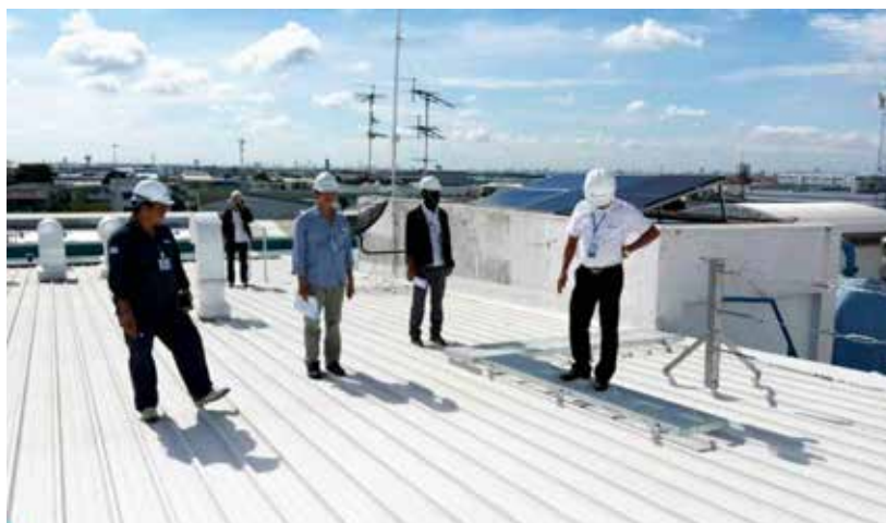
ทีมประหยัดพลังงาน วิศวกรโยธา และทีมงานความปลอดภัยสำรวจโครงสร้างหลังคาโรงงาน เพื่อดำเนินการติดตั้งระบบพลังงานทดแทนซึ่งเป็นหนึ่งในโครงการประหยัดพลังงานของเรา
